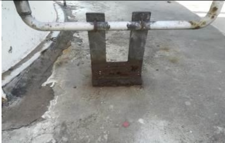
Rusted thermal relief plinth
